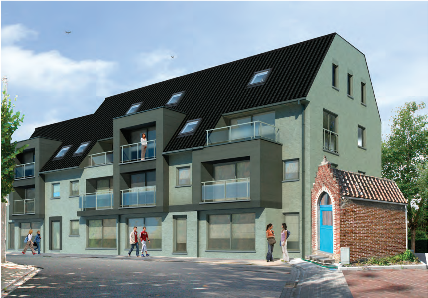
Fig. 1.14 De ‘jumbofermette’ introduceert een fundamenteel nieuwe typologie in dorpskernen en langs linten die een schaalbreuk betekent met de korrel van het dorp.
