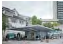
Ferronnerie Dynamo phalt Architekten 2008, Zürich
